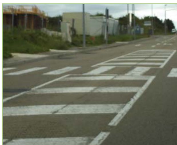
▲ Terre-plein central | marquage au sol
